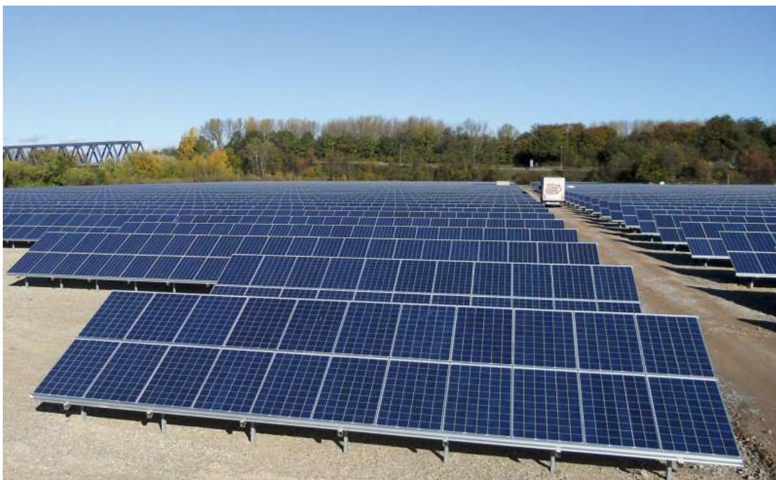
Rys. Elektrownia fotowoltaiczna w Iffezheim (źródło: http://www.wuerth-solar.de/solar/de/wuerth_solar_2012/unternehmen_1/referenzen_4/referenzen_12/referenzen.php
