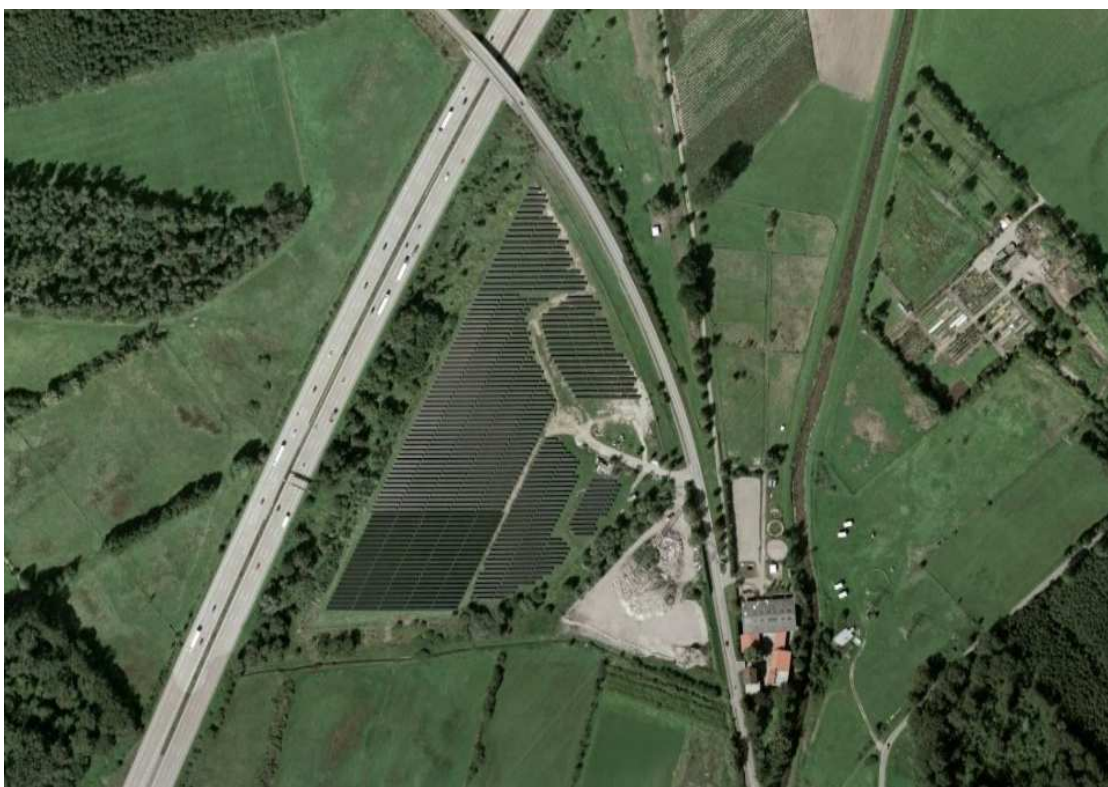
Rys. Elektrownia fotowoltaiczna w Iffezheim (źródło: Google maps).
