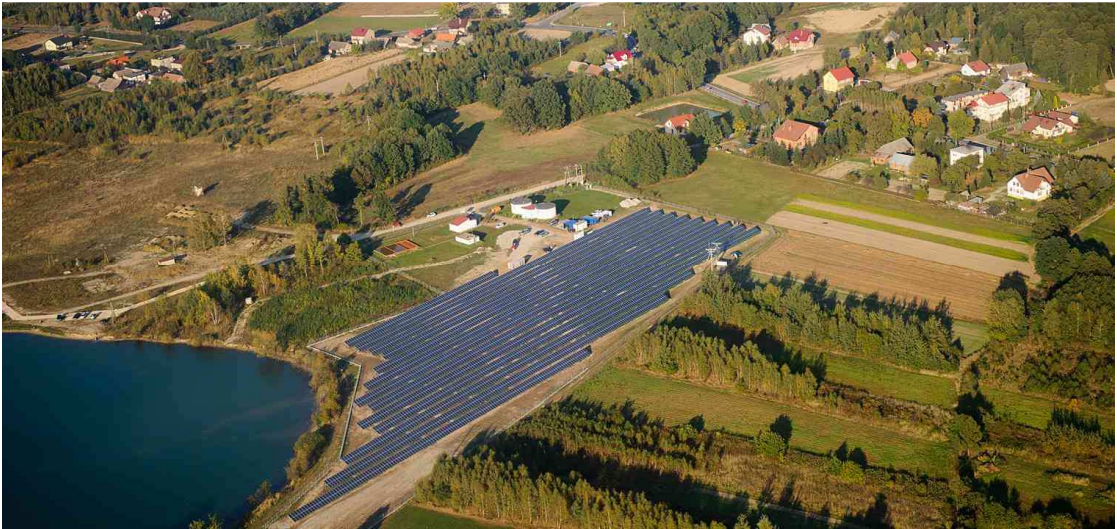
Rys. Elektrownia fotowoltaiczna w Wierchosławicach (źródło: http://www.forumfree.pl 05.12.2012)
